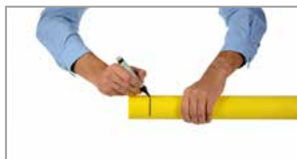
7. Marcar la profundidad de inserción del tubo.
