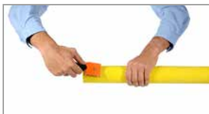
5. Rasar la zona de soldadura del tubo.
