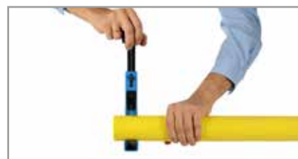
3. Cortar el tubo de forma totalmente recta.
