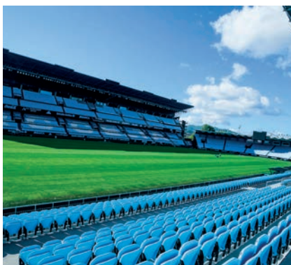
Estadio Nuevo Balaídos (Vigo)
