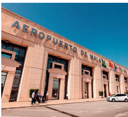
Aeropuerto de Málaga
