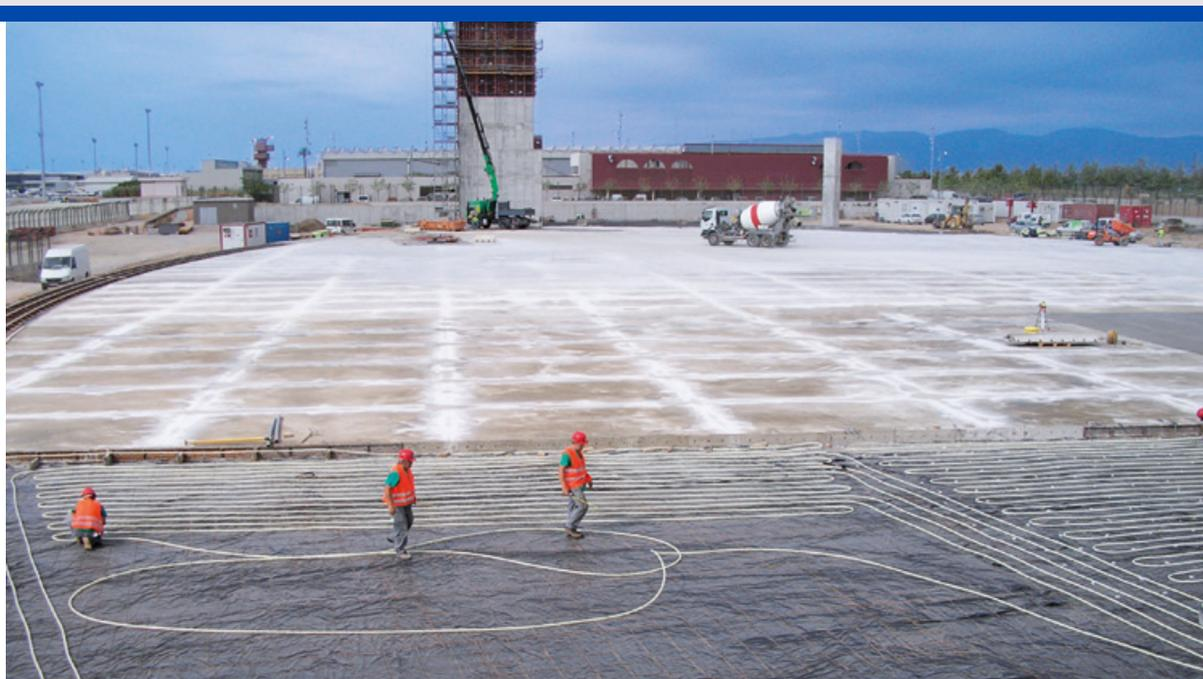
Sistema con circuitos dentro de la solera de hormigón
